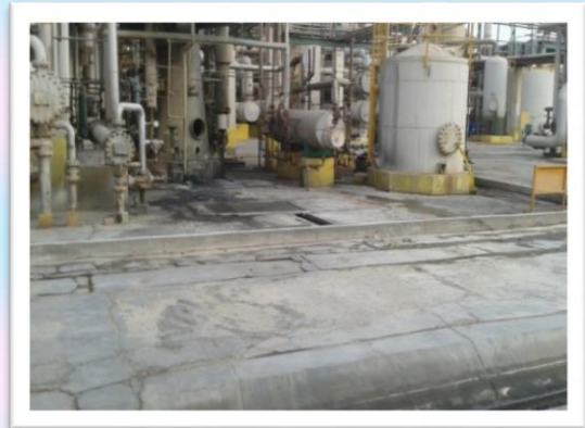
محصور کردن بخش H2S آمونیاک ۱ جهت جلوگیری از نشت پساب آلوده به کانالهای سطحی
