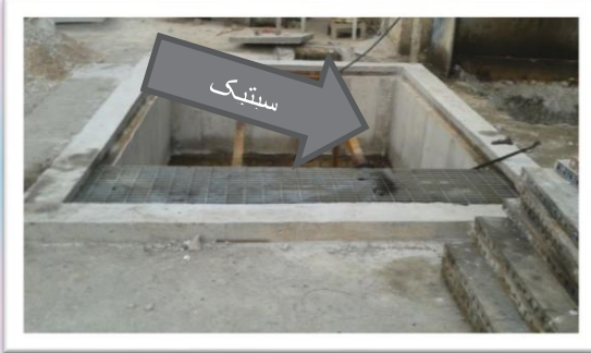
احداث حوضچه شستشو کارگاه ماشین آلات سنگین جهت جلوگیری از ریزش روغن در محوطه کارگاه و انتقال به کانالهای سطحی.
