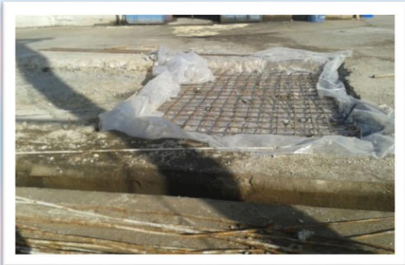
احداث حوضچه شستشو کارگاه ماشین آلات سنگین جهت جلوگیری از ریزش روغن در محوطه کارگاه و انتقال به کانالهای سطحی.
